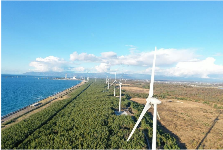
新能代風力発電所 写真（7号機より撮影）
