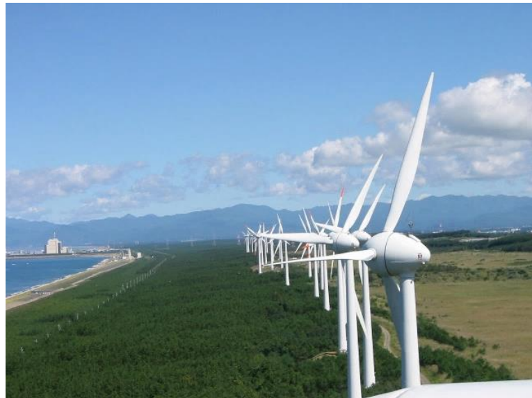
撤去した旧設備（600kW×24基）
